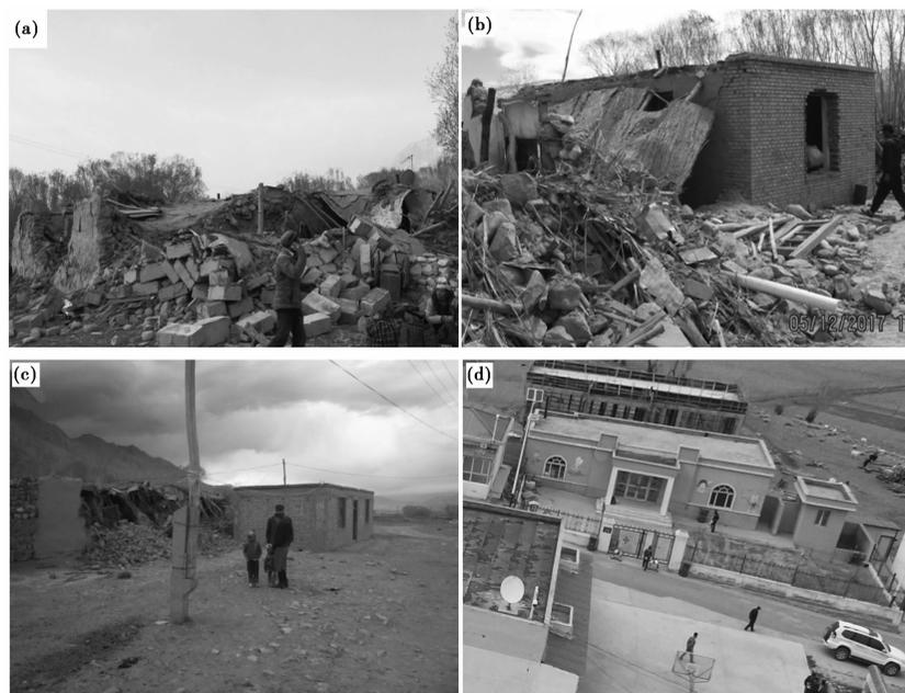
图 2 塔县地震极灾区典型建筑物结构类型
